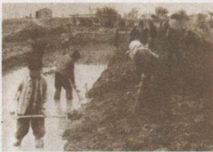
Будівництво іригаційної системи. Одещина. 1949 р.
