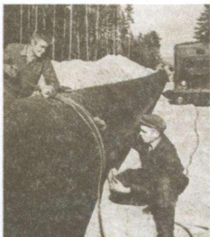
Будівництво газопроводу Шебелинка–Острозька. 1960 р.
