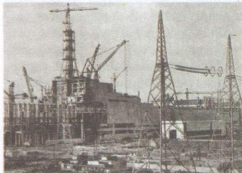
Будівництво першого енергоблоку ЧАЕС. 1978 р.
