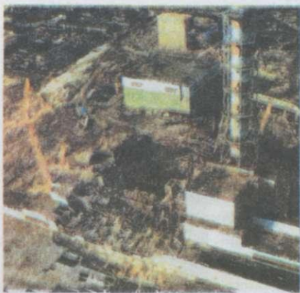
Зруйнований четвертий енергоблок ЧАЕС. 1986 р.
