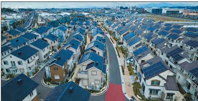
Мал. 2. «Місто Сонця» Фуджисава (Японія), де всі будинки працюють на сонячній енергії.
