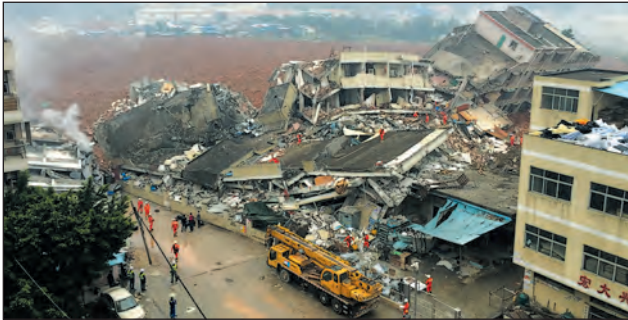
Мал. 3. Зсув ґрунту в місті Шеньчжень (Китай) 20 грудня 2015 р., у результаті якого було зруйновано понад 20 будівель і загинуло 902 людини.
