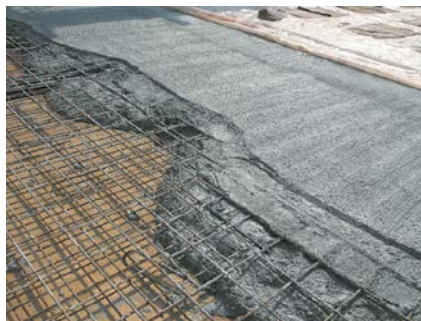
Мал. 30.10. Заливання арматурного каркасу бетоном
