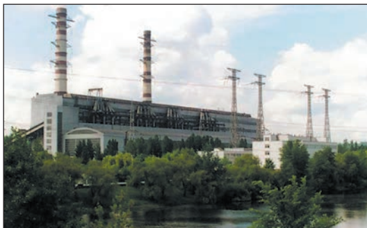
Мал. 2. Трипільська ТЕС. Теплові електростанції спалюють паливо, нагрівають воду та перетворюють її на пару, яка подається під тиском на турбіни. Електроенергія, вироблена на Трипільській ТЕС, надходить споживачам Київської, Житомирської та Черкаської областей.
