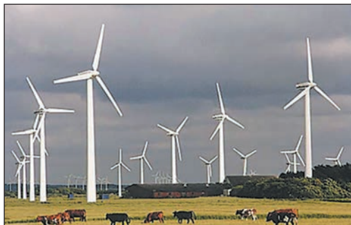
Мал. 4. Ботівєвська ВЕС — найбільша вітрова електростанція України, розташована поблизу села Приморський Посад (Запорізька обл.). Завдяки великій протяжності узбережжя, досвіду проектування, будівництва й експлуатації ВЕС, серійному виробництву обладнання та державній підтримці Україна має добрі перспективи використання енергії вітру.
