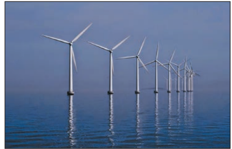
Мал. 2. Шельфова вітрова електростанція Лілгранде (Швеція) має високу ефективність через регулярний морський вітер. Електроенергія передається на землю через підводні кабелі.
