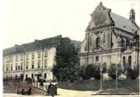
Колишня головна будівля Львівського університету 1851–1923 рр.
