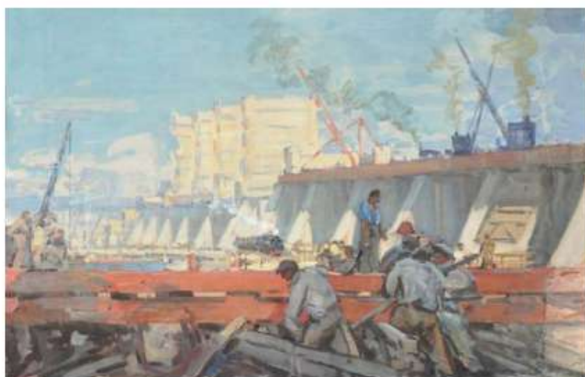
Олексій Шовкуненко. Будівництво греблі ДніпроГЕСу
