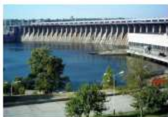
Дніпрогес Дніпровська гідроелектростанція
