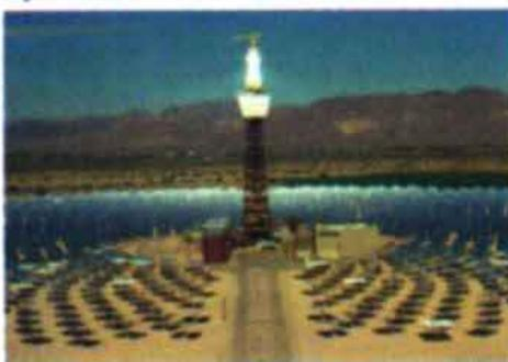
Мал. 9. Сонячна електростанція з геліоконцентратором
