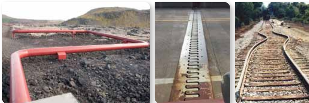
Мал. 180. Теплове розширення конструкцій
