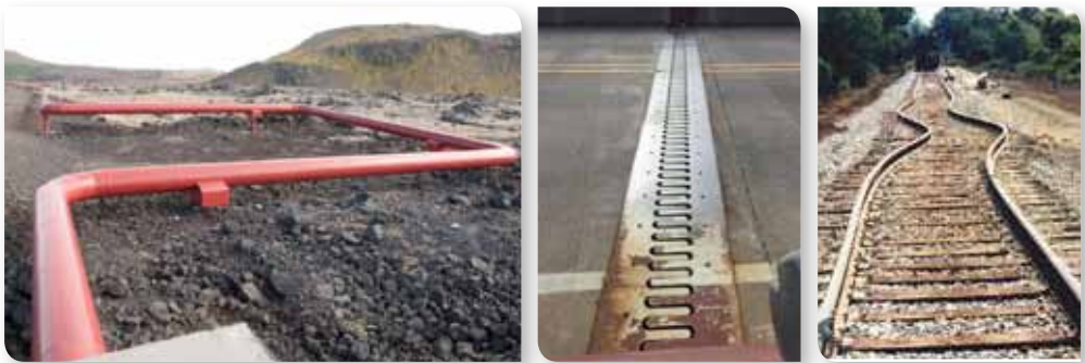
Мал. 236. Теплове розширення конструкцій
