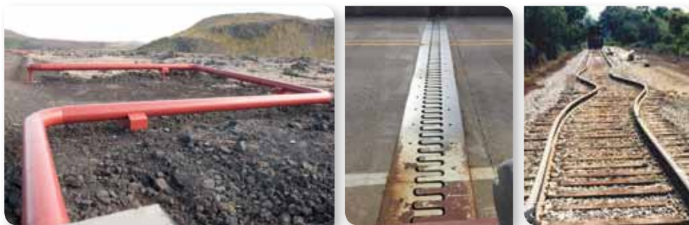
Мал. 140. Теплове розширення конструкцій
