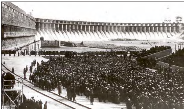
Будівництво Дніпрогес у Запоріжжі. 1930-ті рр.
