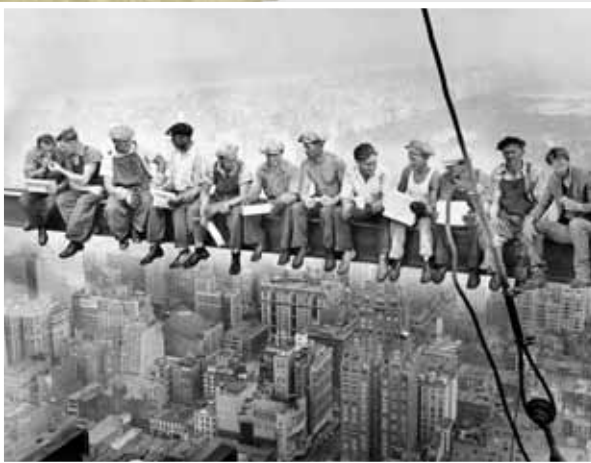
Робітники на будівництві хмарочосу в Нью-Йорку: обідня перерва
