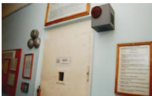
Іл. 11.4. Кімната для зберігання зброї з металевими ґратами на вікнах і дверях й охоронною сигналізацією
