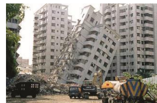
Іл. 40.15. Наслідки землетрусу
