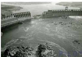
Іл. 40.8. Зруйнована вибухом гребля Дніпрогесу в 1941 р.
