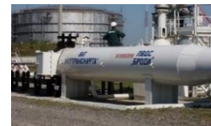
Іл. 43.11. Нафтоперекачувальна станція (Одеса – Броди)
