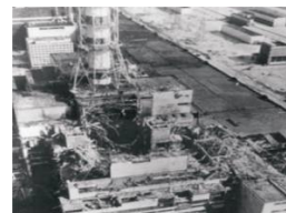
Іл. 40.10. Аварія на Чорнобильській АЕС
