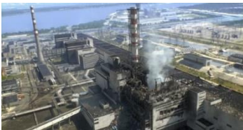
Іл. 41.2 Аварія на Чорнобильській АЕС
