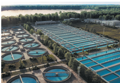
Станція для очищення стічних вод
