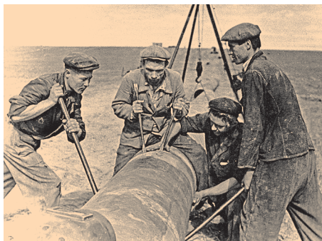
Прокладання першого магістрального газопону «Дашава–Київ». Фото. 1948 р.
