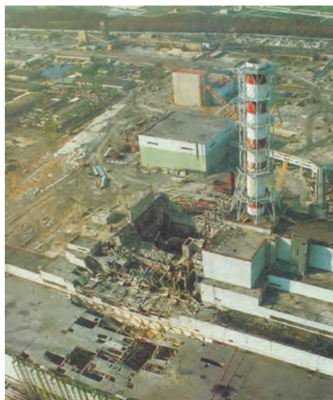
↑ Зруйнований четвертий реактор ЧАЕС
