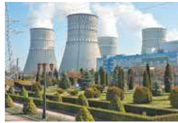
Fig. 42.7. CAE Rivnenisica: 4 blocuri atomice energetice cu puterea totală de 2835 MW
