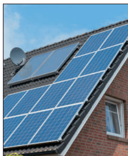
Fig. 38. Panouri solare pe acoperișul casei
