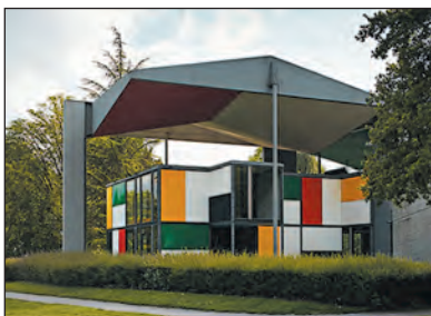
Павільйон Хейді Вебер. Архітектор Шарль Ле Корбюзьє. Цюрих (Швейцарія). 1963—1967 рр.
