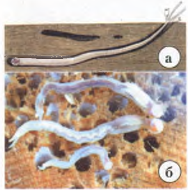
Рис. 15.13. Корабельний черв (а) та зруйнована ним деревина (б)
