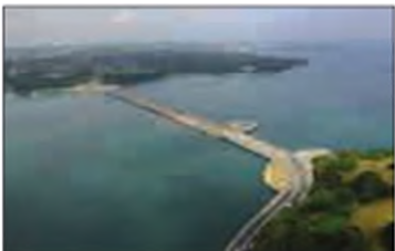
Мал. 3.12. Припливна електростанція у Франції, яка водночас відіграє роль моста
