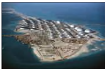
Мал. 3.40. Нафтовий портовий комплекс Рас-Таннуре в Саудівській Аравії, який приймає одночасно десятки нафтоваливних суден — танкерів
