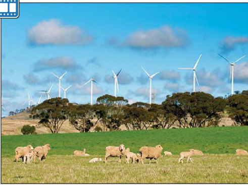
Мал. 2.132. Просторі рівнини використовуються як пасовища, а підвищені ділянки зайняті вітровими електростанціями
