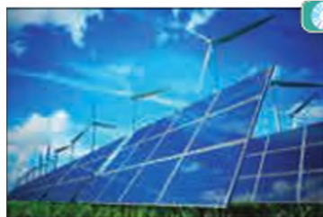
Мал. 4.4. Сонячна і вітрова електростанція у Нідерландах
