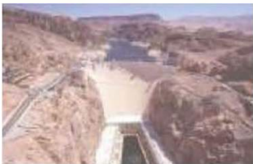
Мал. 85. Гідроелектростанція на річці Колорадо
