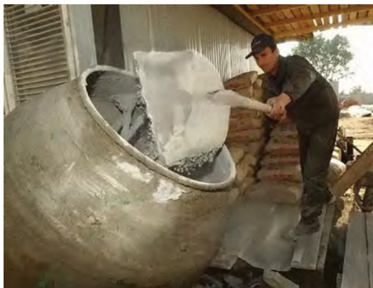
Мал. 2. Замішування цементного розчину
