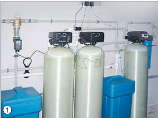
Рис. 29.5. 1. Фільтри для системи очищення води в замському будинку. 2. Фільтр-кувшин із змінним картриджем
