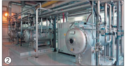
Рис. 29.4. 1. Приміщення сучасної станції водопідготовки. 2. Озонаторна
