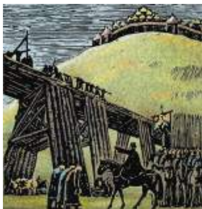
↑ Будівництво мосту через Дніпро Володимиром Мономахом. Художник Ю. Логвин. 1979 р.
