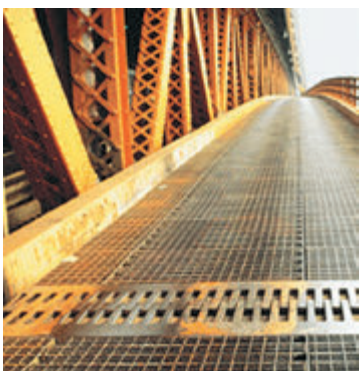
Рис. 2.6. Щоб міст не вигинався під час спеки й не руйнувався в холоди, його виготовляють з окремих секцій, з'єднаних спеціальними зчленуваннями (ряди зубців змикаються під час спеки й розходяться під час холодів)
