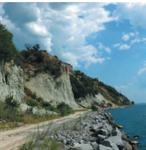
Мал. 24.6. Руйнування берегів Кременчуцького водосховища і забування камінням для запобігання абразії (біля підніжжя горба Пивиха)
