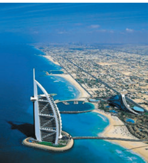
Мал. 44.9. Дубай за короткий час із містечка в пустелі на березі Перської затоки перетворився на багатофункціональне сучасне місто
