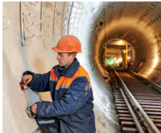
Creuser des tunnels
