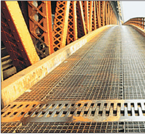
Рис. 2.6. Щоб міст не руйнувався, його виготовляють з окремих секцій, з'єднаних спеціальними зчленуваннями (ряди зубців змикаються під час спеки й розходяться під час морозів)
