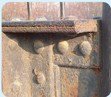
Мал. 131. Заклепкове з'єднання
