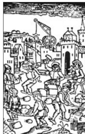
◆ Рис. 8. Каменярі за роботою. Міське будівництво. Мініатюра XVI ст.
