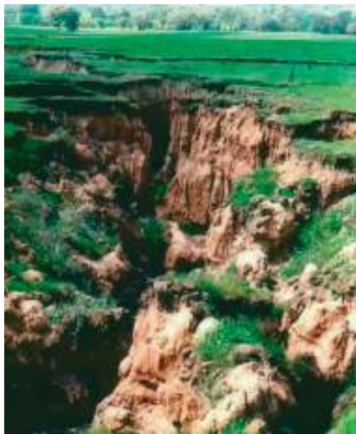
Іл. 57.1. Ґрунтова ерозія
