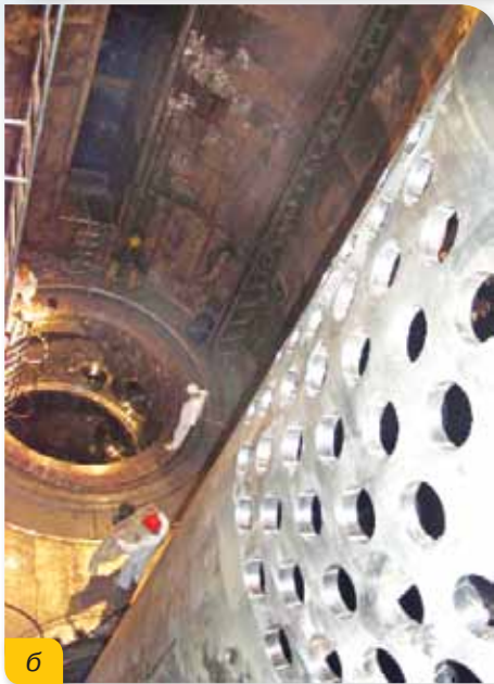
Мал. 213. Реактор ВВЕР-1000: а — схема будови; б — монтаж реактора на Рівненській АЕС
