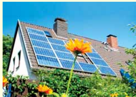
Мал. 65. Встановлення сонячної батареї як спосіб енергоощадження
