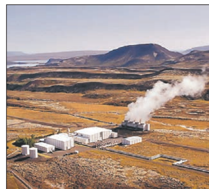
Мал. 3. Геотермальна електростанція в Ісландії.
