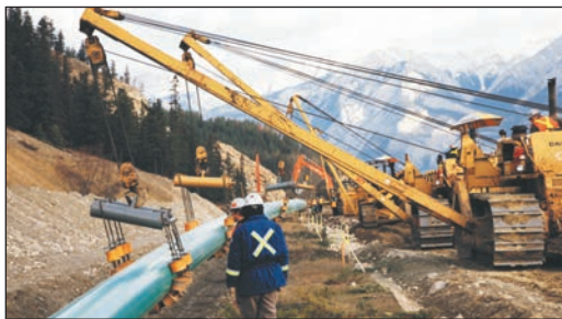
Мал. 1. Спорудження трубопроводу великого діаметра в США.
