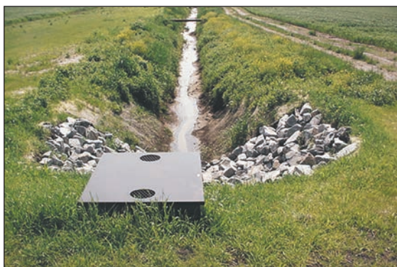
Мал. 6. Дренажний осушувальний канал.
