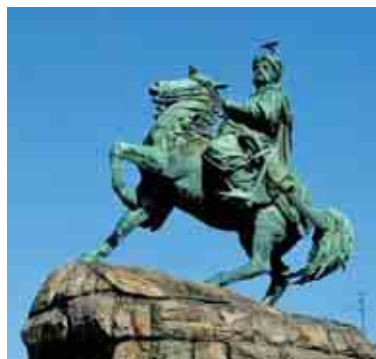
Мал. 31. Пам'ятник Богдану Хмельницькому. Бронзова фігура у вологому повітрі вкривається зеленим нальотом основного купрум(II) карбонату \text{Cu}_2(\text{OH})_2\text{CO}_3
