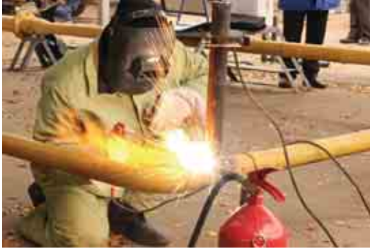
Мал. 50. Для ацетилено-кисневого зварювання металу (а) використовують спеціальне обладнання (б)
