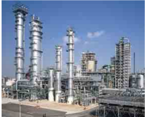
Мал. 55. Загальний вигляд нафтопереробного заводу
