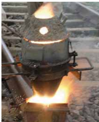
Рис. 19.5. Термітний процес, який винайшов у 1898 р. німецький інженер Ганс Гольдшмідт, супроводжується виділенням великої кількості теплоти. Тому його застосовують для зварювання й різання металів. Завдання. Схарактеризуйте термітний процес з погляду окиснення-відновлення, класифікуйте цю реакцію за числом і складом реагентів і продуктів
