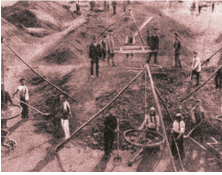
Ручне сортування (сухе збагачення) марганцевої руди на Покровських марганцевих шахтах. Фото. 1906–1907 рр.
