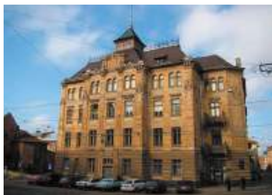
← Будівля страхового товариства «Дністер» у Львові. 1905–1906
