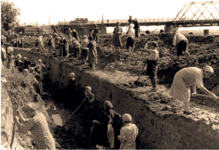
Будівництво протитанкових укріплень (1941 рік)
