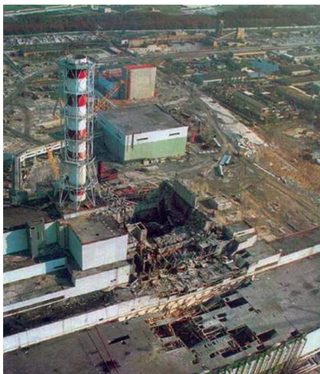
Зруйнований реактор Чорнобильської атомної електростанції
