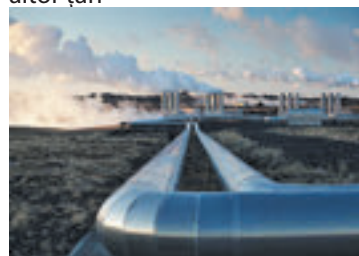
Fig. 12. Asigurarea termică a capitalei Islandiei Reykjavikului este complet realizată de centrala geotermică, situată la 7 km de la oraș
