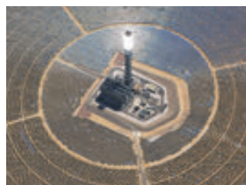
Fig. 10. Una dintre cele mai mari centrale electrice solare din lume – «Ivanpah» (SUA, California). 173 de mii de oglinzi reflectă lumina solară și o orientează spre vârful a trei turnuri, unde sunt instalate cazanele cu apă. Aburul fierbinte este furnizat pe paletele turbinelor, instalate în interiorul turnurilor.
