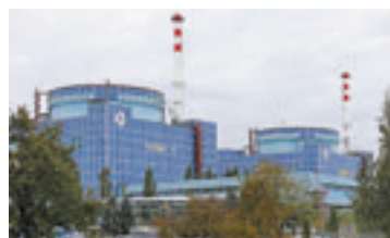
Fig. 27.6. CAE Hmelinița are 2 blocuri atomice energetice
