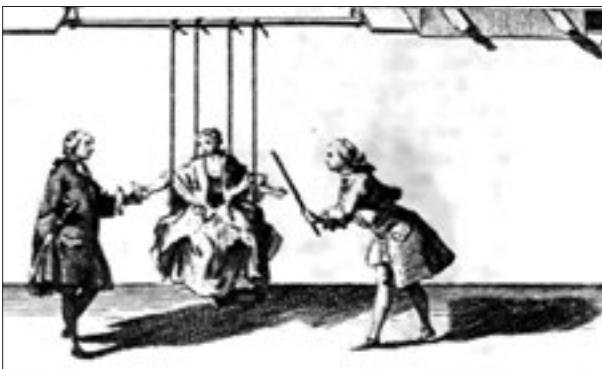
Fig. 40.6. Experiența care demonstrează existența conductorilor și dielectricilor (gravură din mijlocul sec. XVIII). Femeia șade într-un scrânciob, suspendat cu sfori de mătase. Bărbatul, situat la dreapta, apropie o tijă din sticlă electrizată de mâna femeii, iar cel din partea stângă, se atinge de cealaltă mână a ei – apare scânteia
