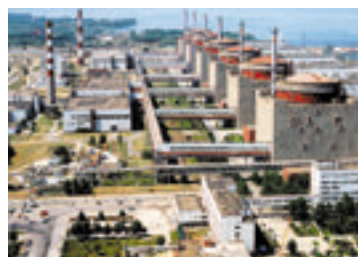
Fig. 27.3. CAE Zaporizica – cea mai mare centrală atomoelectrică din Europa, la ea funcționează 6 blocuri atomice energetice
