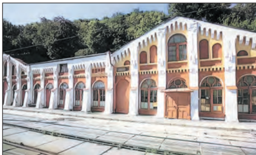
Clădirea mecanică a stației inferioare a sistemului de alimentare cu apă din Kyiv
