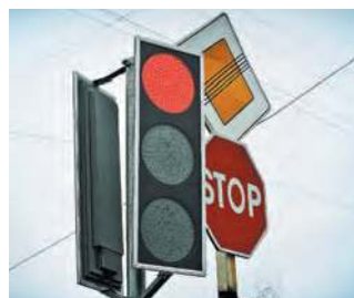
9.3. ábra. A modern közlekedési lámpák fénye még erős napfényben is könnyen észlelhető. Ezekben a berendezésekben az izzószálas lámpákat LED lámpákkal cserélték fel
