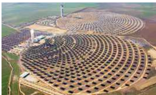
189. ábra. Naptornyok a villamos-áram termelésére Sevilla város közelében (Spanyolország)
