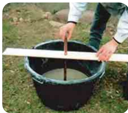
Мал. 210. Приготування бетонної суміші
