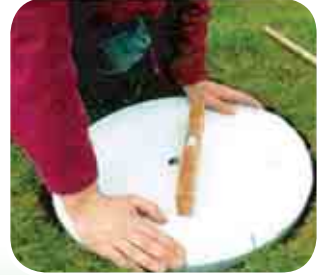
Мал. 213. Встановлення бетонного круга
