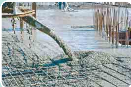
Мал. 26. Залізобетон — композит, який використовують у будівництві
