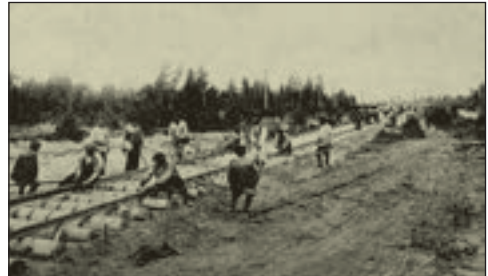
Будівництво Транссибірської залізниці
